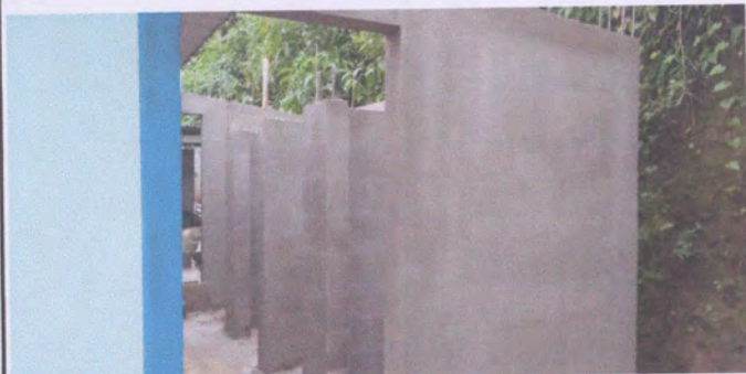
Foto 3: Construcción de sanitarios
