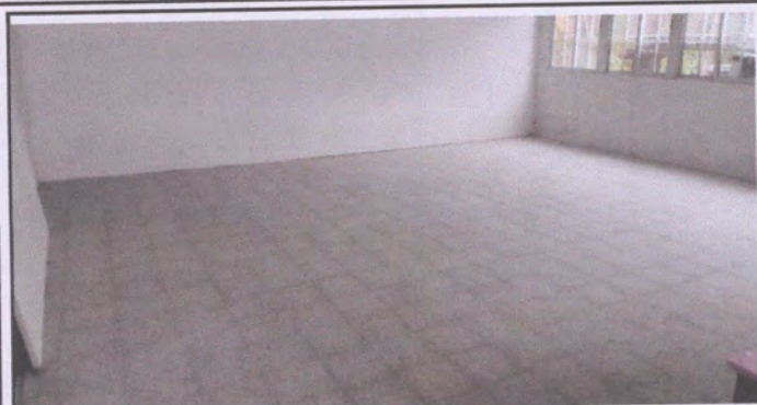
Foto1: Reparación de piso y construcción de pared
