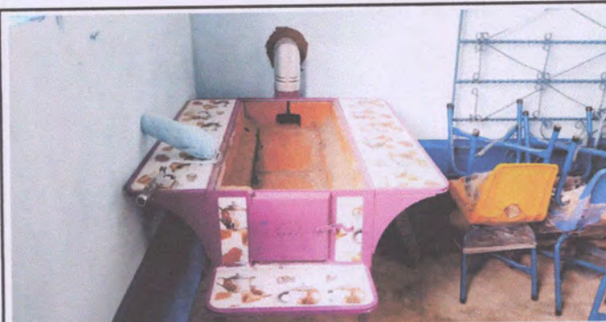
Foto 4: Instalación de nueva plancha de cocina
